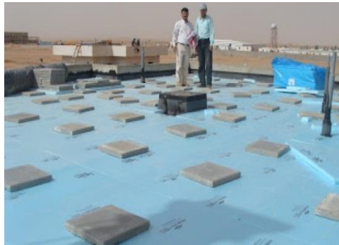
شكل رقم (21) ألواح البولسترين للأسقف قبل العزل المائي
