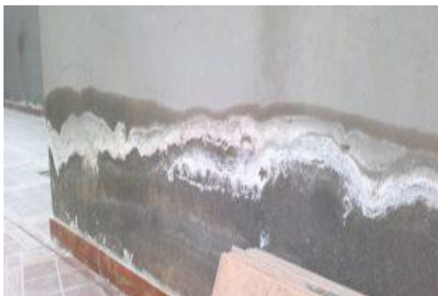
شكل رقم (24) ظهور الرطوبة والتكلسات على الجدران
