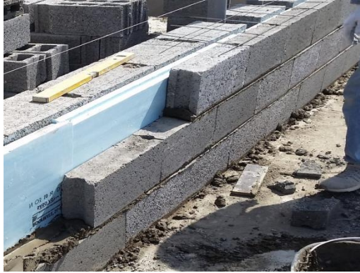
شكل رقم (17) عزل الجدران باستخدام الواح البوليسترين
