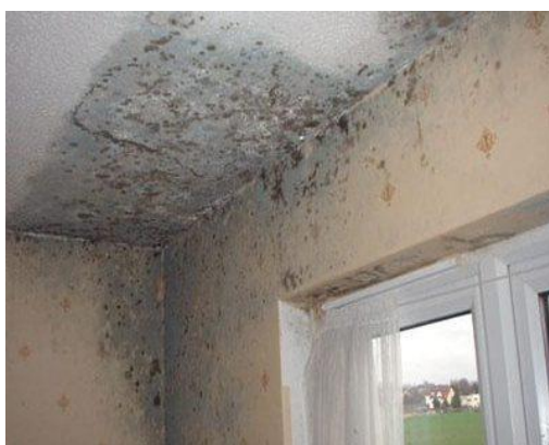
شكل رقم (26) ظهور الرطوبة من الاسقف
