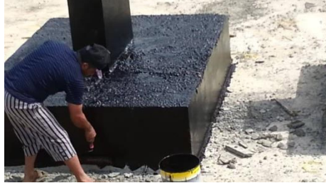
شكل رقم (15) عزل القواعد باستخدام البيتومين
