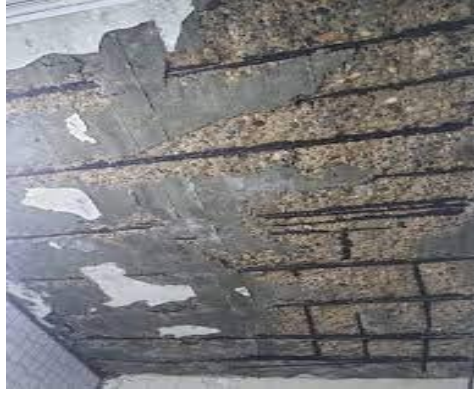
شكل رقم (27) تساقط قصارة السقف وصدأ الحديد
