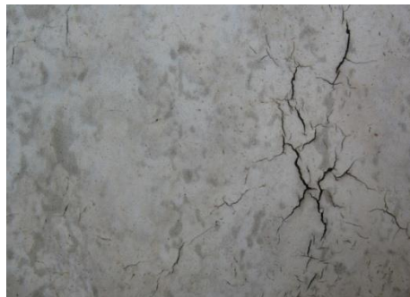
شكل رقم (23) تشققات بسبب تغير درجات الحرارة
