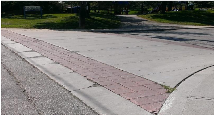
صورة (4): تقاطعات المشاة المرتفعة
