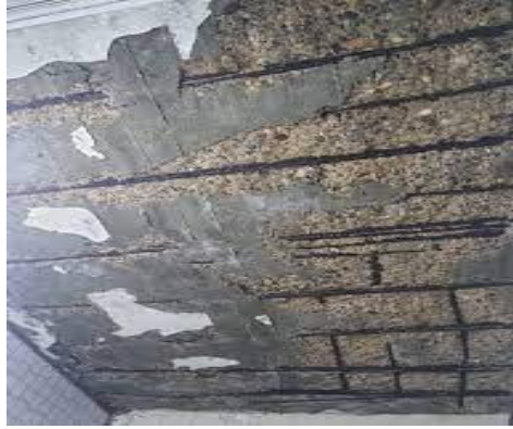
شكل رقم (27) تساقط قصارة السقف وصدأ الحديد
