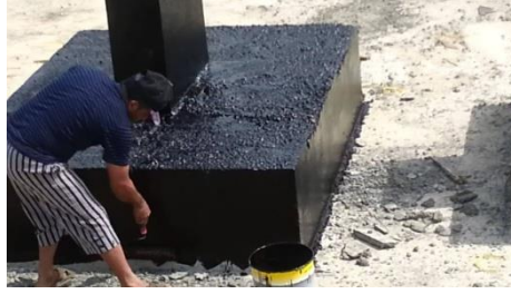
شكل رقم (15) عزل القواعد باستخدام البيتومين
