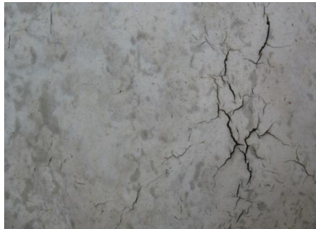
شكل رقم (23) تشققات بسبب تغير درجات الحرارة
