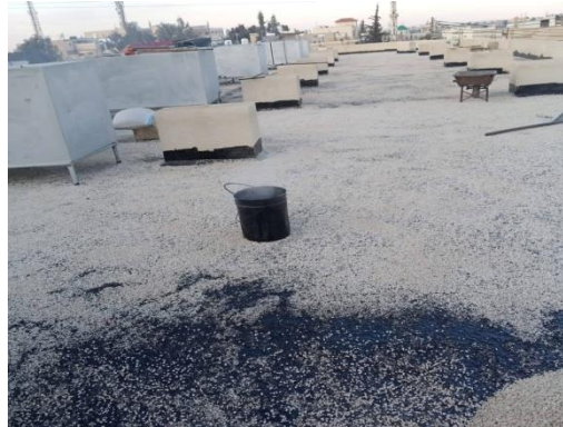
شكل رقم (20) عزل باستخدام البيتومين السائل لاحد مشاريع بلدية الظليل
