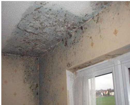
شكل رقم (26) ظهور الرطوبة من الاسقف
