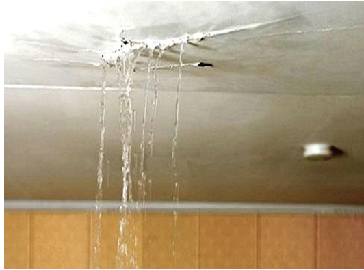
شكل رقم (27) تساقط قصارة السقف وصدأ الحديد
