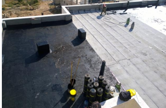
شكل رقم (19) عزل باستخدام لفائف الاسفلت لاحد مشاريع بلدية الظليل
