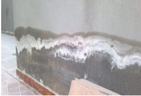
شكل رقم (24) ظهور الرطوبة والتكلسات على الجدران
