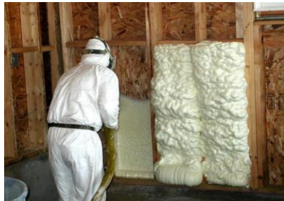
شكل رقم (5) العزل الحراري باستخدام رغوة البولي يوريثين
