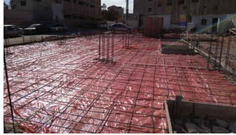
شكل رقم (16) عزل باستخدام مشمع البولي ايثيليناسفل المدة الارضية لاحد مشاريع بلدية الظليل
