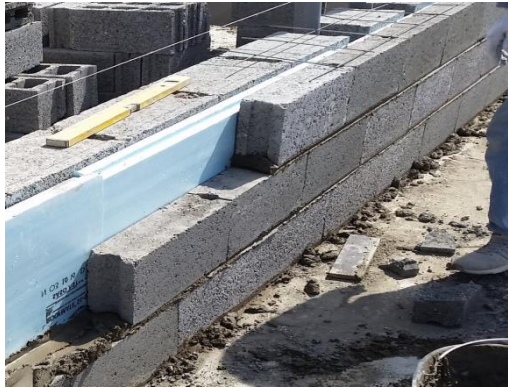
شكل رقم (17) عزل الجدران باستخدام الواح البولستيرين
